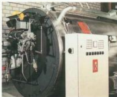
Ölgefeuerter Wärmeträgererhitzer in Kompaktbauweise Oil-fired heater in compact design
