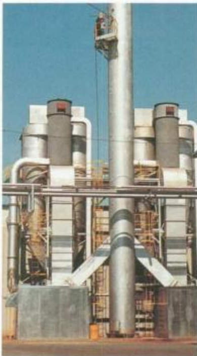
Feststoffgefeuerte Wärmeträgererhitzer für Schleifstaub und Holzspäne Solid fuel-fired heaters for sander dust and shavings
